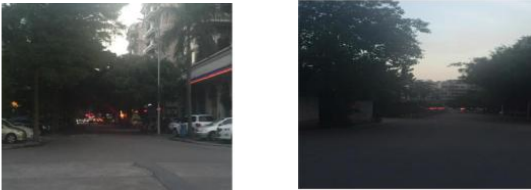
图 3.1-1 道路改建前状况实景图
