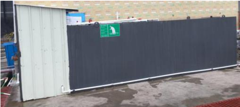
图 4-1 污水一体化处理装置图
