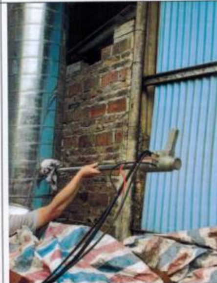
图 9.4 混合搅拌工序废气处理前检测口 ○Q3
