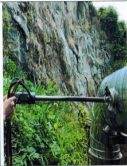
图 9.2 生产车间废气处理前检测口 ○Q1
