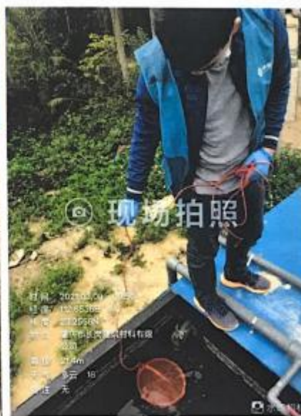
生活污水处理后排放口
