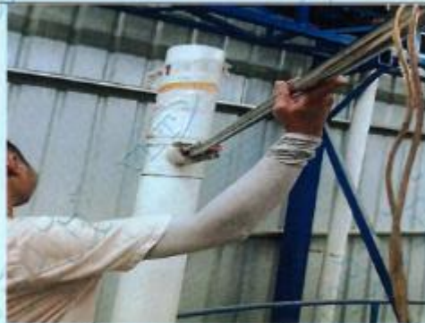
筒仓顶部呼吸孔及底部粉尘排气筒
